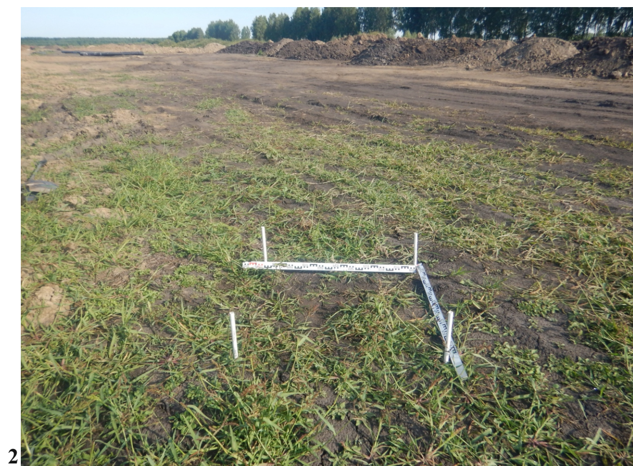
Илл. 19. Брянская область. Суземский район. 2019 год. Шурф 3. 1 - место закладки, вид с ЮВ; 2 - дневная поверхность, вид с Ю.
