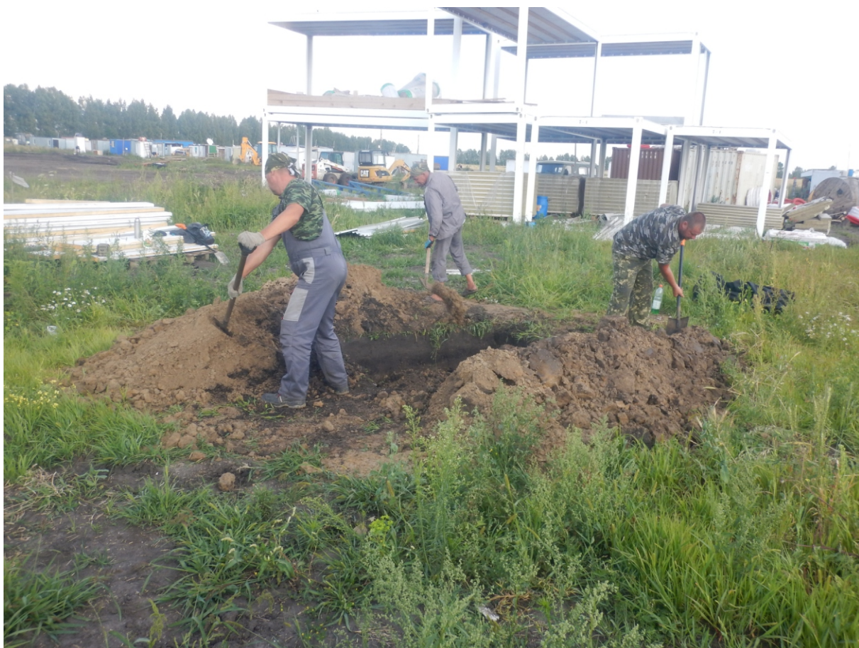
Илл. 12. Брянская область. Суземский район. 2019 год. Процесс работ. Засыпка шурфов.
